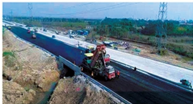
庐山路（南二路一场北四路）拓宽改造工程 项目投资额：0.8亿元 服务内容：招标代理
