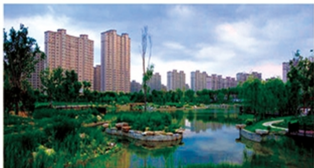
胜利花苑居住区3区2#、6#、7#、10#--13#工程
